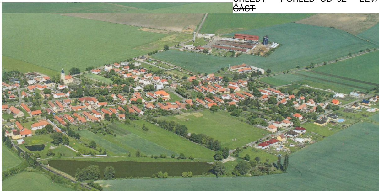
CHLEBY – POHLED OD JZ – PRAVÁ ČÁST
